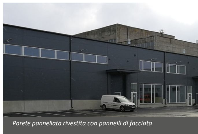
Parete pannellata verniciata
