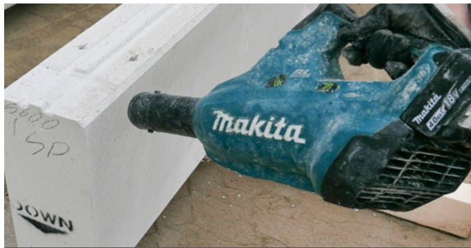
Dopo la fresatura, rimuovere il materiale sciolto dalla superficie del pannello.
