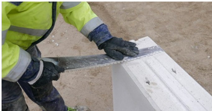
Fresatura dell'incavo per l'ancoraggio di fissaggio.
