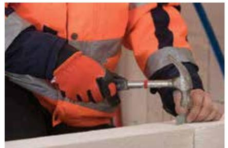
Placer la première plaque et la corriger sur le terrain avec le maillet en caoutchouc. Appliquer la colle sur le bord du carreau suivant et le positionner fermement contre le premier carreau. Pour fixer les carreaux les uns aux autres, utiliser les bandes de jonction bauroc. Ainsi, les carreaux ne bougeront pas une fois l'adhésif durci, ce qui facilite la pose des cloisons de séparation.
