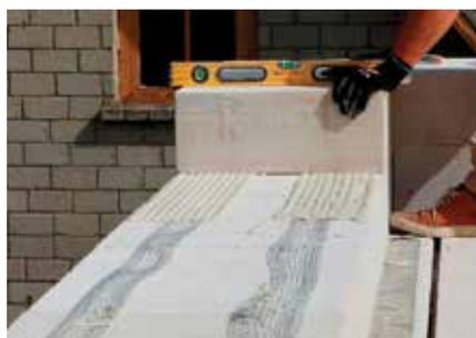
**Renforts.** Utilisé pour renforcer les joints d'étanchéité des murs, Murfor Compact-A est placé directement sur la surface du bloc nettoyé. Selon la largeur du bloc, il peut être nécessaire de poser un ou deux maillages de la bonne largeur de Murfor Compact-A. Appliquer la colle à béton cellulaire sur l'armature et poser la rangée de blocs suivante. La quantité de colle doit être suffisante pour garantir une portabilité suffisante des blocs.
