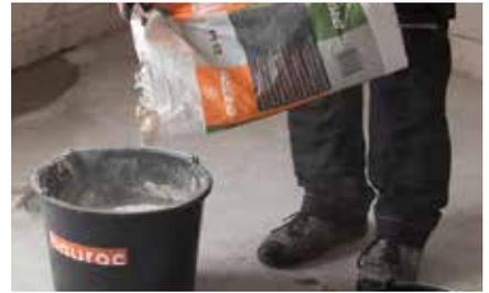
Il indique la position des cloisons sur les murs et au sol, vérifie la planéité et l'orientation de la chape si nécessaire. Pour faciliter l'installation du mur, fixer un support vertical au mur existant et une table au sol. Mélanger la COLLE À BÉTON CELLULAIRE bauroc selon les instructions indiquées sur l'emballage de l'adhésif.
