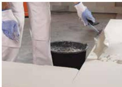
**Joints verticaux.** Mélanger l'eau avec la COLLE À BÉTON de bauroc dans un récipient en suivant les instructions sur l'emballage jusqu'à obtention du mélange adhésif qui convient. Remplir ensuite les rainures aux extrémités verticales des blocs avec le mélange pour assurer l'étanchéité à l'air des joints verticaux.
