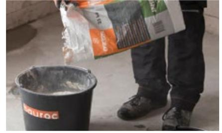
Segnala la posizione di divisori sui muri e sul pavimento, controllando la planarità e, se necessario, livellando il massetto. Per facilitare la posa del muro, attaccare un supporto verticale al muro esistente e un tavolo sul pavimento. Miscelare l'ADESIVO CALCESTUZZO CELLULARE bauroc seguendo le istruzioni riportate sulla confezione dell'adesivo.
