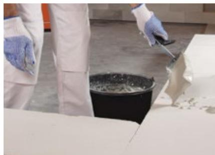
**Giunti verticali.** Mescolare in un contenitore l'acqua con l'ADESIVO CALCESTRUZZO CELLULARE bauroc seguendo le istruzioni riportate sulla confezione fino ad ottenere la miscela adesiva adatta. Quindi riempire le scanalature alle estremità verticali dei blocchi con la miscela per garantire la tenuta all'aria dei giunti verticali.
