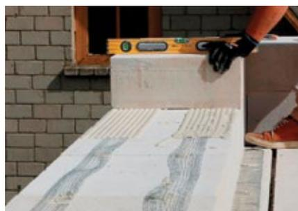
**Rinforzo.** Murfor® Compact-A, usato per rinforzare le murature nei giunti, viene applicato direttamente sulla superficie pulita del blocco. A seconda della larghezza del blocco, è necessario installare una o due reti di rinforzo Murfor® Compact-A adiacenti di larghezza adeguata. Applicare l'ADESIVO CALCESTRUZZO CELLULARE sul rinforzo e posare la fila successiva di blocchi. La quantità dell'adesivo deve essere sufficiente da fornire la tenuta adeguata fra i blocchi.
