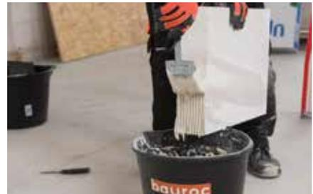
Befestigen Sie einen Streifen aus erweitertem Polystyrol 10 mm dick und so breit wie die Trennplatte, mit dem Kleber auf dem Boden (Sie können auch Bitumenrollen verwenden, zwei Schichten auftragen). Tragen Sie eine homogene Schicht des Klebstoffs mit dem kleinen Schlitten mit Sägezähnen auf das Polystyrol und auf den Rand der Trennwand auf um sicherzustellen, dass der Rand der Platte für die gesamte Länge richtig bedeckt ist. Die erste Reihe kann mit dem Zementmörtel verlegt werden.
