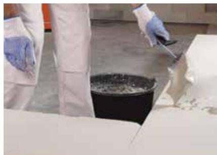
**Vertikale Dichtungen**. Das Wasser mit dem CONCRETE ADHESIVE bauroc in einem Behälter verrühren, gemäss den Anweisungen auf der Verpackung, bis das entsprechende Klebstoffgemisch erhalten ist. Dann füllen Sie die Rillen an den senkrechten Enden der Blöcke mit dem Gemisch um die Luftdichtigkeit der vertikalen Dichtungen zu gewährleisten.
