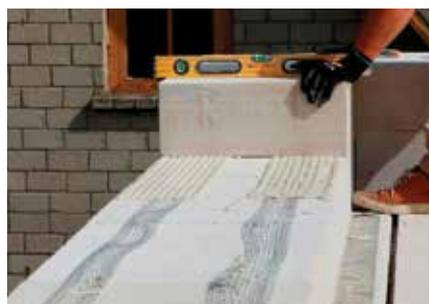
**Verstärkungen**, Murfor Compact-A, benutzt um die Mauerdichtungen zu verstärken, wird direkt auf die Oberfläche des gereinigten Blocks gelegt. Je nach Breite des Blocks ist es notwendig eine oder zwei Netze mit der richtigen Breite von Murfor Compact-A zu verlegen. Den Porenbetonkleber auf die Verstärkung auftragen und die nächste Blockreihe verlegen. Die Quantität des Klebers sollte so sein dass ein genügend grosse Tragbarkeit der Blöcke gewährleistet ist.
