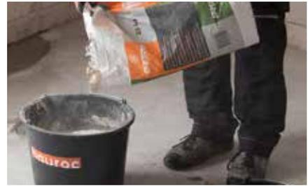
Es gibt die Position der Trennwände an den Wänden und auf dem Boden an, überprüft die Flachheit und, wenn nötig, die Ausrichtung des Estrich. Um das Verlegen der Wand zu erleichtern, befestigen Sie eine vertikale Stütze an der bestehenden Wand und einen Tisch auf dem Boden. Mischen Sie die bauroc PORENBETONKLEBER nach den Anweisungen auf der Klebstoffverpackung.
