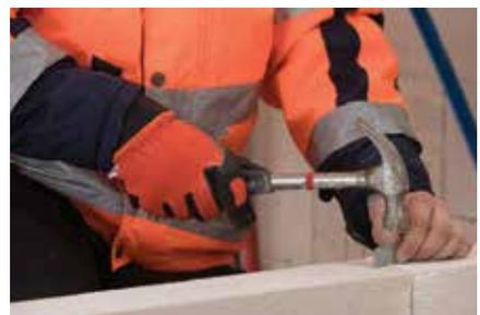
Legen Sie die erste Platte und korrigieren Sie mit dem Gummihammer an Ort und Stelle. Den Kleber am Rand des nächsten Panels auftragen und fest gegen die erste Platte positionieren. Um die Paneele miteinander zu befestigen, verwenden Sie die bauroc-Kupplungsstreifen. Auf diese Weise bewegen sich die Platten erst, wenn der Klebstoff gehärtet ist, so dass die Trennwände leichter zu verlegen sind.
